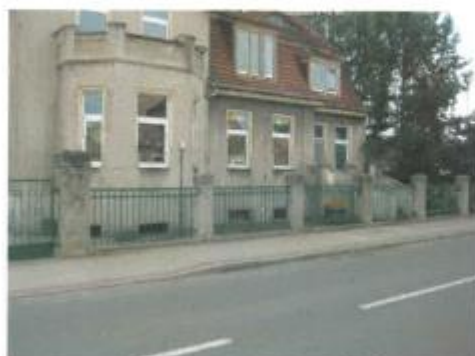
Sąsiednia zabudowa po przeciwnej stronie ul. Kościuszki
